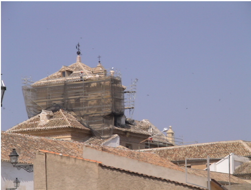
Convento de las Carmelitas Descalzas. Vista trasera.
