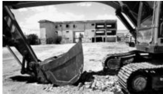
Parte del inmueble que aún queda por derribar.
